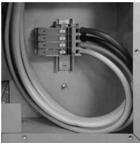
Abb. 24: Klemmen in der Anschlussbox
